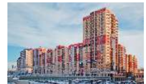
ЖК «Солнечный город», Казань «АК БАРС Строй»
